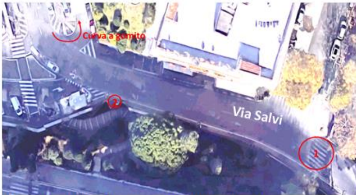
Figura 6 Il tratto di strada di via Salvi con situazioni critiche
